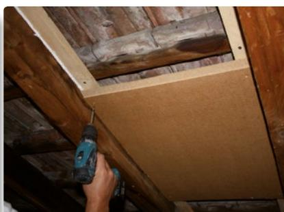
8. Presser fermement GUTEX Multiplex-top sous le lattis et appliquer GUTEX Abdichtmasse, puis le fixer dans le lattis.
