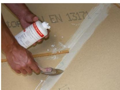
4. Appliquer une couche d'apprêt GUTEX sur le panneau de sous-toiture GUTEX, puis laisser aérer.
