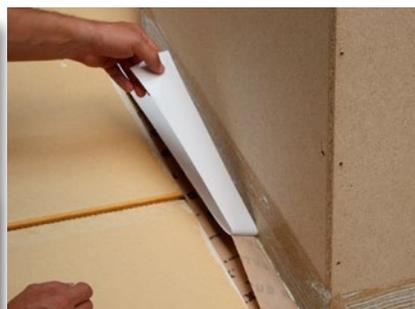
3. Coller le ruban GUTEX Klebeband proprement et sans plis sur le raccord, en aplanissant bien le mastic d'étanchéité.
