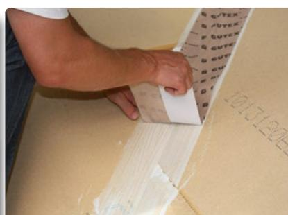
6. Coller le ruban GUTEX proprement et sans plis sur le panneau de sous-toiture GUTEX, en aplanissant bien le mastic d'étanchéité.
