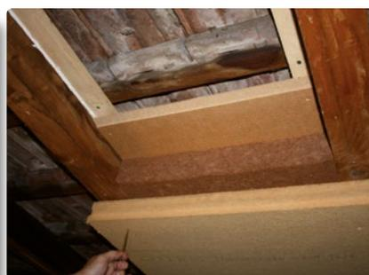
9. Poursuivre le montage vers l'intérieur avec GUTEX Thermosafe-wd avec rainure et languette avant de poser l'étanchéité à l'air et le frein vapeur.
