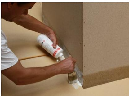
1. Appliquer une couche d'apprêt GUTEX sur le panneau de sous-toiture GUTEX et la surface de raccord, puis laisser aérer.
