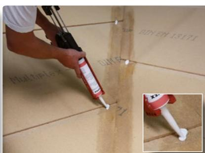
5. Colmater parfaitement le profil avec un cordon de mastic GUTEX Abdichtmasse.
