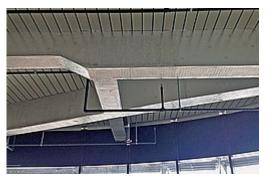
Panneau isolant stable de forme et résistant à la compression, avec revêtement alu sur une face. Revêtement anti-feu de poutres et sommiers en acier avec durée de résistance au feu de 30 à 180 min, ainsi que de 30 à 120 min pour les piliers en acier.
