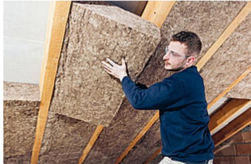
Panneau isolant élastique de différentes largeurs avec zone déformable spéciale du côté longitudinal. Utilisation dans la construction bois avec des écartements entre 460 et 700 mm.
