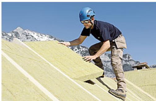
Panneau isolant bicouche avec couche inférieure élastique et couche supérieure plus dure. Isolation sur chevrons des pans inclinés pour la toiture "Flums" et "Eiger" ou entre lambourdes. Isolation des dalles et planchers de comble.
