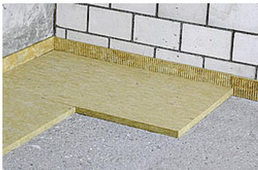
Panneau isolant résistant à élasticité permanente pour une isolation fiable contre le bruit de chocs pour chapes flottantes avec contrainte normale dans la construction d'appartements et de bureaux.
