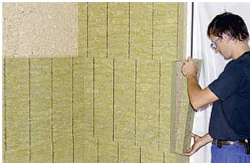
Panneau homogène avec surface spéciale pour une bonne adhérence du crépi. Idéal pour retour sur embrasure jusqu'à 50 mm.
