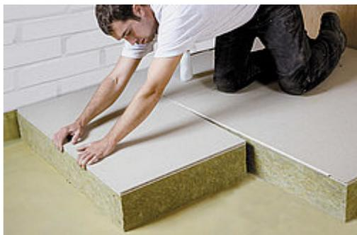
Panneau isolant homogène combiné avec un panneau aggloméré rainuré de 16 mm comme élément isolant praticable pour plancher de combles. Livré avec languettes d'assemblage en bois dur.
