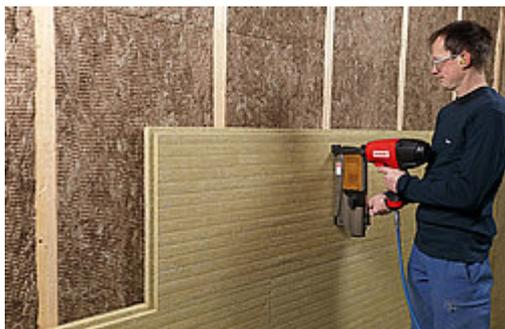
Panneau isolant incombustible, résistant à la compression, avec rainure et crête de tout côté. Couche d'isolation en pleine surface pour les façades ventilées, fixée directement sur l'ossature en bois.
