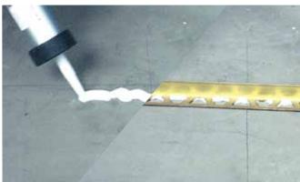
La largeur du joint (10 mm maxi) est généralement le double de profondeur.
