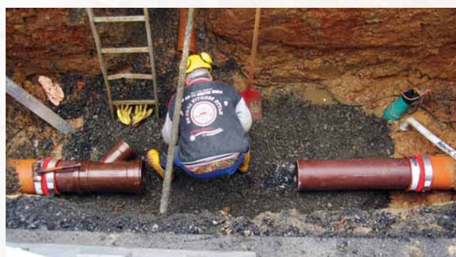
Réparation de conduites défectueuses
