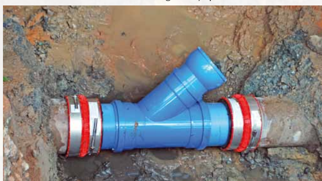
Ajout après coup d'un branchement dans une conduite en grès déjà posée
