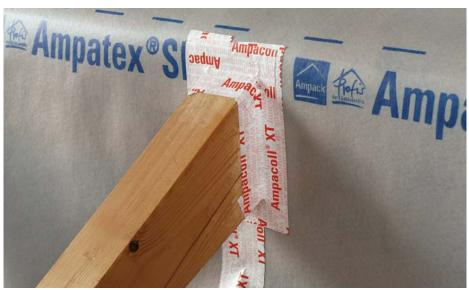
Collages d'angle et d'équerre – 30 mm sur une face, 30 mm sur l'autre face
