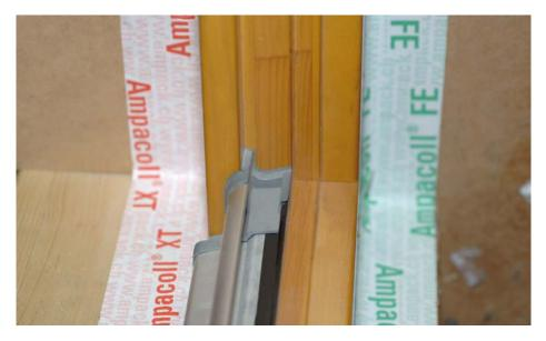
Montage de fenêtre – 12 mm en guise de raccord entre le ruban adhésif et le châssis de fenêtre, le reste (48 mm) sur l'embrasure
